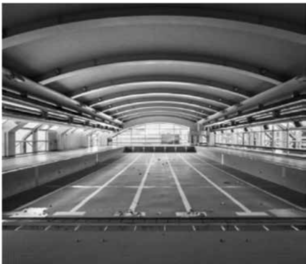
写真-7 プール（改修前）
