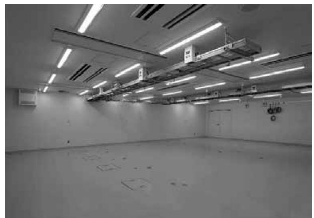
写真-6 プレハブ保管庫スペース（改修後）
