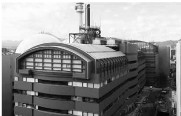
写真-1 建物外観（ガスビル(手前)と3号館(奥)）
