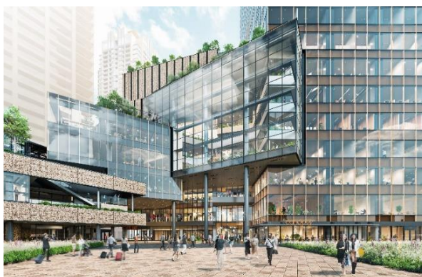
施設の外観（北館）
