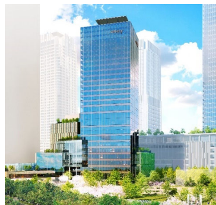
北街区賃貸棟
